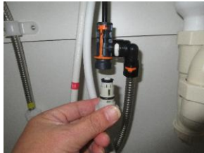
洗面台下の水抜栓
