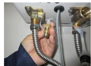
給湯器の水抜栓
