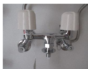
洗濯用水栓の水抜栓
